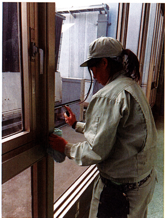
事務所窓清掃作業
