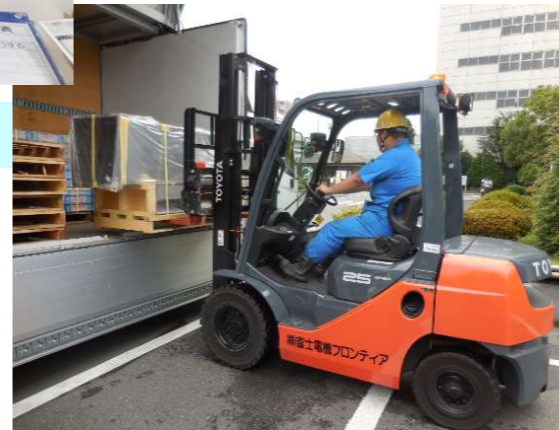
フォークリフト（荷降し）作業
